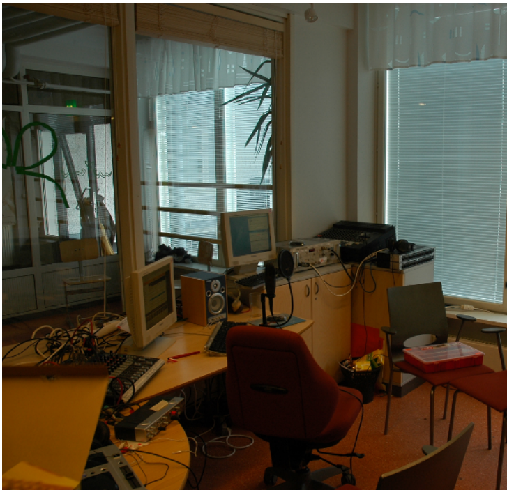
Studiota rakennetaan, Vihanti 2010
